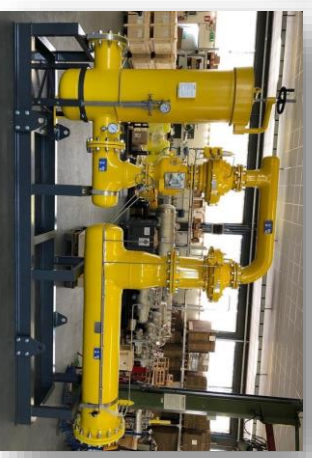
Costruzione piping PED a misura secondo richiesta cliente.
